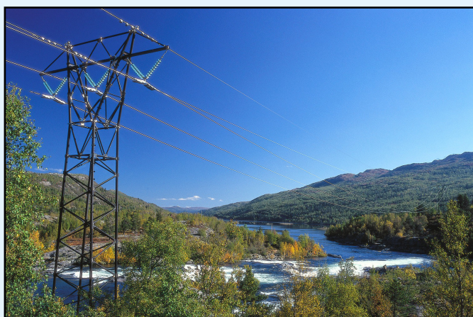
Power lines, Frøystul. © Norsk Hydro.
