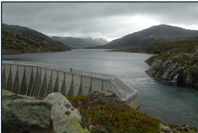
Dam - Røldal Suldal hydro power system. © Norsk Hydro.
